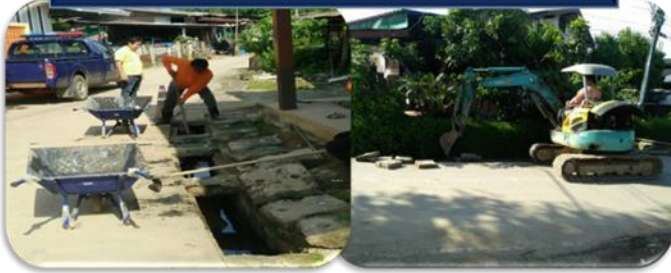
โครงการจ้างเหมาบริการบำรุงรักษาดถนน ท่อระบายน้ำ หมู่ที่ ๑ บ้านใต้
