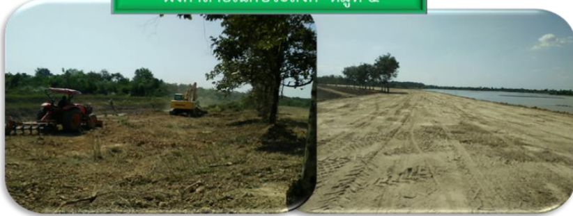
โครงการปรับปรุงภูมิทัศน์บริเวณหนองรี ฝั่งศาลาอเนกประสงค์ หมู่ที่ ๕
