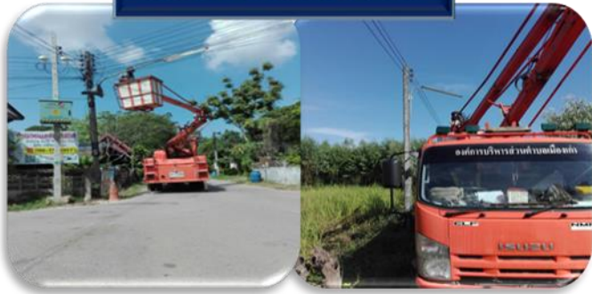
ซ่อมแซมไฟฟ้าในตำบลเมืองเก่า
