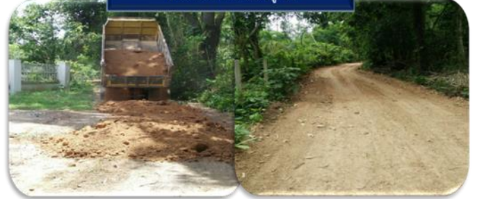
โครงการก่อสร้างถนนดินลูกลัง
