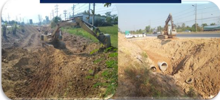
โครงการก่อสร้างวางท่อระบายน้ำ หมู่ที่ ๓
