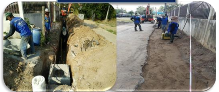
โครงการก่อสร้างวางท่อระบายน้ำ
