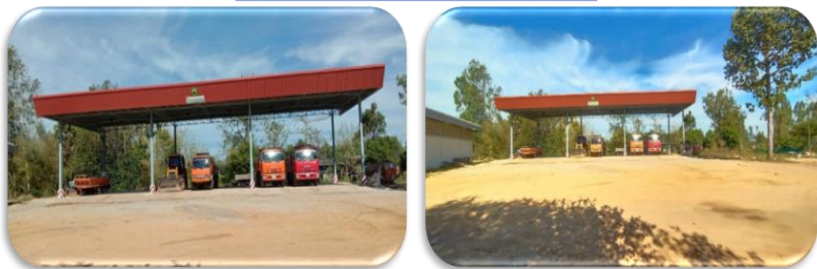
โครงการก่อสร้างโรงจอดรถ
